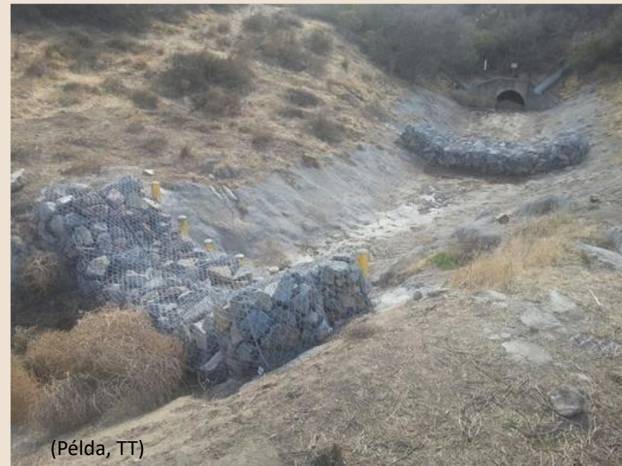
„C” változat: gát építése gabionból
