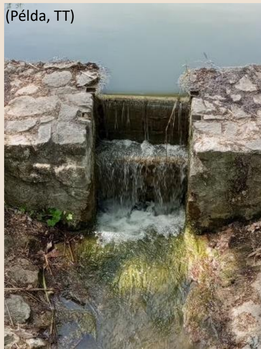
„B” változat: habarcsba rakott terméskő burkolat fapallókkal
